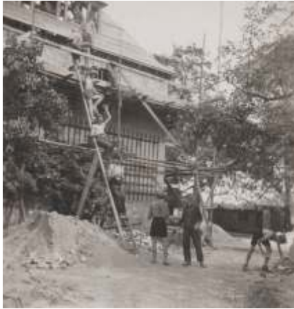
Dachschalung am Vater-Höhne-Haus
