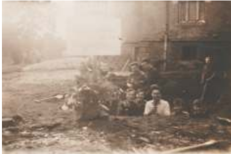
Bau des Kohlebunkers am Rühlehaus
