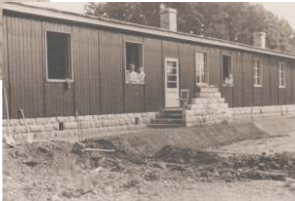
neue Baracke am Brüderhaus
